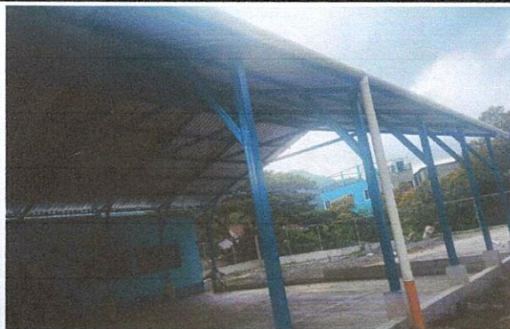
Foto1: Caida de aguas pluviales (COLOCACION DE TUBERIA) ya finalizada.
