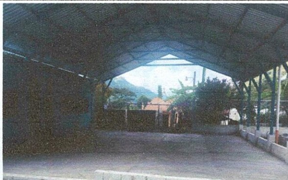
Foto 1: losa de patio ya finalizado.
