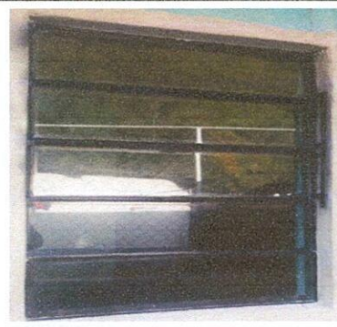
Foto 6: ventanas y vidrios ya instalados.
