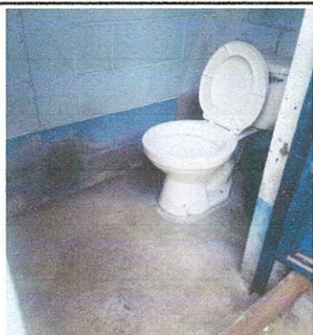
Foto 3: sanitarios nuevos ya instalados.
