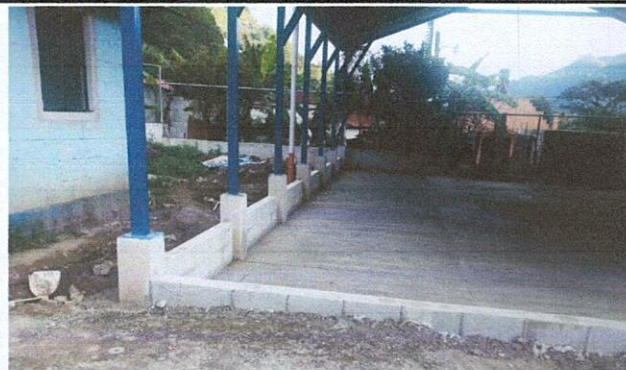
Foto 2: Levantamiento de block al contorno de la losa de patio ya finalizado.
