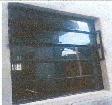
Foto 5: ventanas y vidrios ya instalados.
