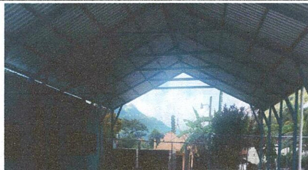
Foto 2: Estructura y techo ya finalizado.
