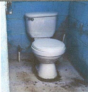
Foto 4: baños ya finalizados.
